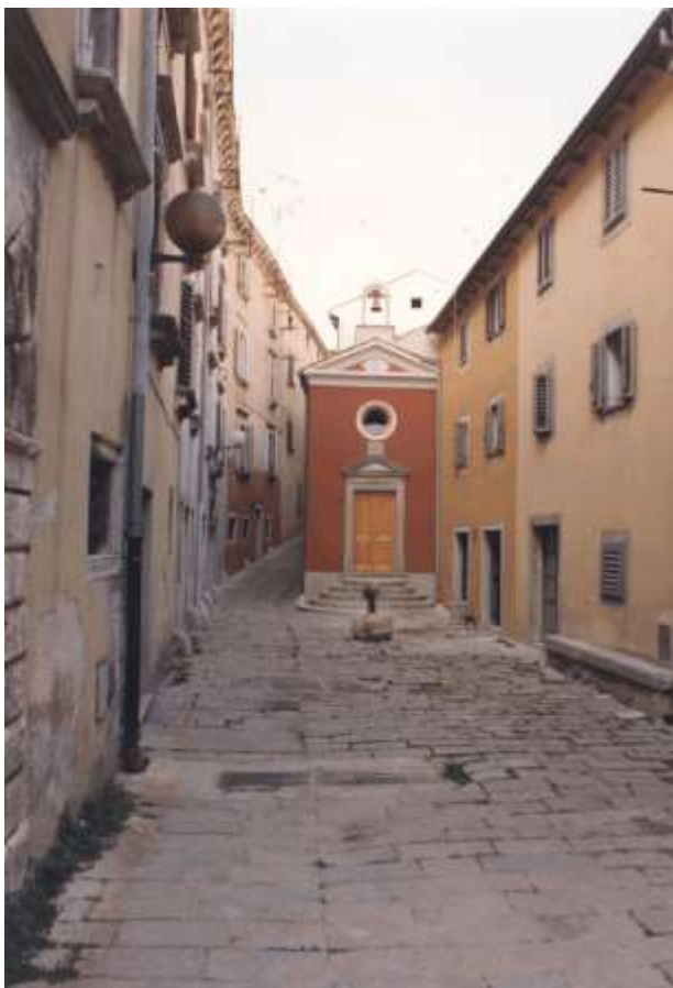
Pogled na sanirani objekt / srpanj 1993.g.
