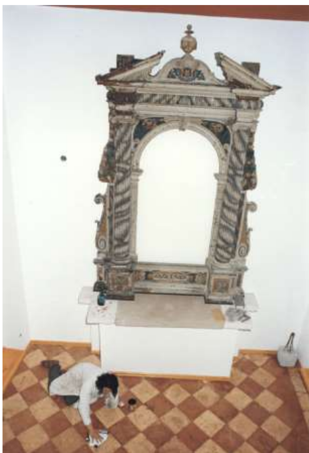
Čišćenje, brušenje, saniranje i poliranje terracota poda geometrijskog uzorka / svibanj 1993.g.
