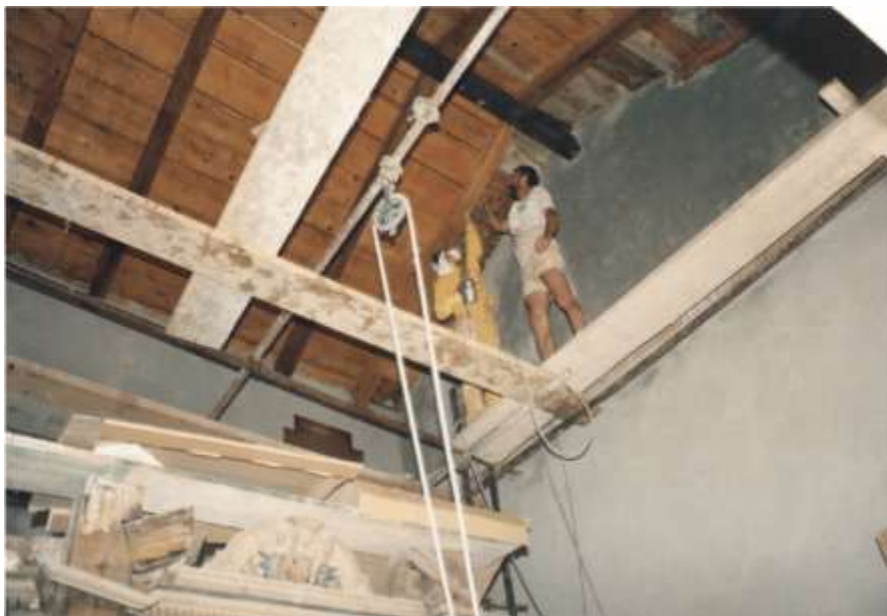
Priprema i zaštita krovišta pred bojanje drvene građe / svibanj 1992.g.
