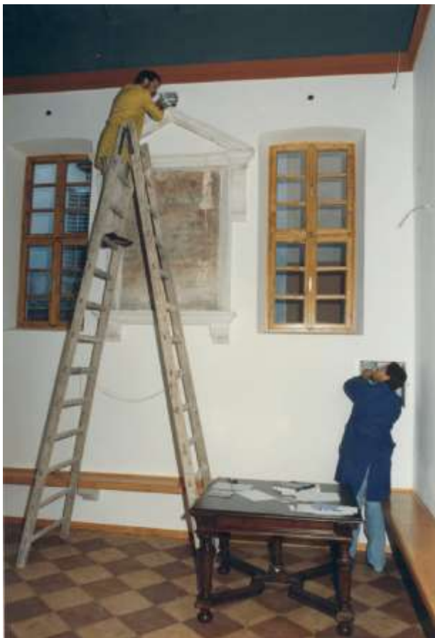
Postav elektroinstalacija i namjenske galerijske rasvjete / svibanj 1993.g.
