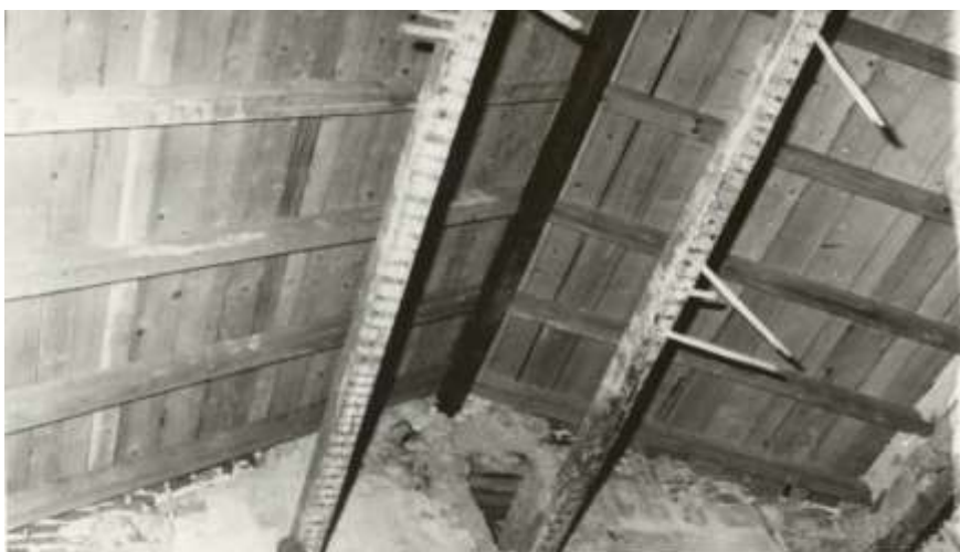
Pogled na sanirano krovšte / listopad 1991.g.
