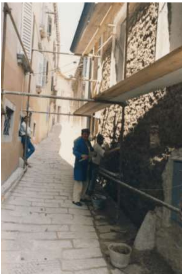
Otvoreno gradilište – skidanje stare žbuke i postavljanje prvog sloja grube žbuke / travanj 1992.
