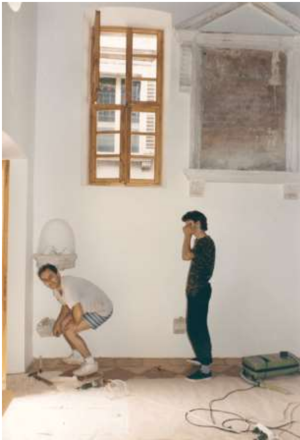
Montaža novih ulaznih vratiju, prozora sjevernog zida i okulusa izrađenih prema rekonstrukciji stare građe – Stolarija Jadrejčić / lipanj 1993.g.
